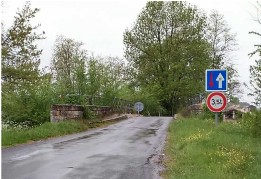
Pont surplombant la voie ferrée des TER (Photo CE)
